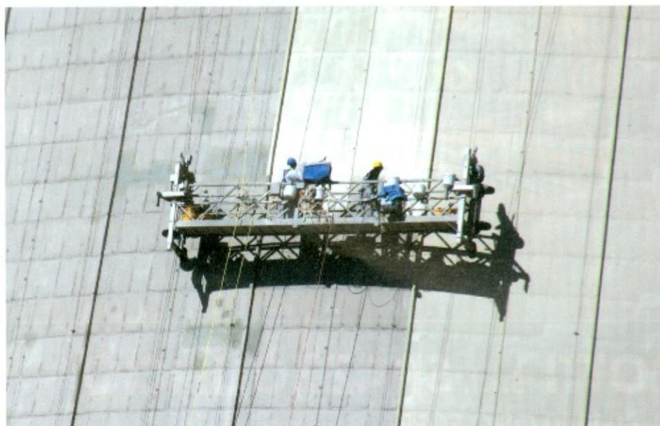
non è possibile seguire la prima di queste tre possibilità e rimangono praticabili solo le ultime due. La norma **UNI EN 280:2013** è, esattamente, una norma di tipo C e stabilisce i criteri di stabilità, di costruzione, di sicurezza e definisce gli esami e le prove inerenti le **piattaforme di lavoro mobili elevabili (PLE)** che sono macchine rientranti in Allegato IV, in quanto apparecchi per il sollevamento di persone con caduta verticale superiore a tre metri.
